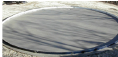
Pour and Complete Concrete Floor Slab
