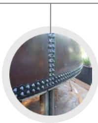
MONTÁŽ LUBŮ RENOVOVANÝCH PLECHŮ
