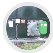
NOVÉ MÍCHADLO ELEKTROINSTALACE
