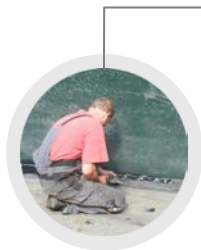
TMELNÍ SPOJŮ KOTEVNÍHO PÁSKU
