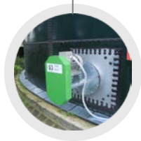
MONTÁŽ TECHNOLOGIÍ ČERPADLA - MÍCHADLA
