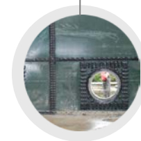
MONTÁŽ PŘÍRUB RENOVOVANÉ
