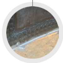
VNITŘNÍ SVÁR KOTEVNÍHO PÁSKU
