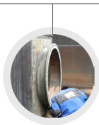
DEMONTÁŽ REVIZNÍHO VSTUPU
