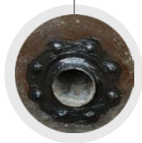
MONTÁŽE PŘÍRUB VČETNĚ TMELENÍ
