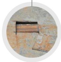
KONTROLNÍ SONDA OCELOVÉ PODLAHY
