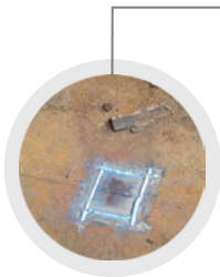
OPRAVA PODLAHY NEBO VÝMĚNA ZA NOVOU
