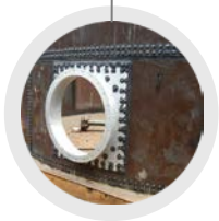
MONTÁŽ REVIZÁKU VČETNĚ TMELENÍ SPOJŮ
