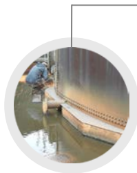
BROUŠENÍ SPOJŮ DEMONTÁŽ NÁDRŽE
