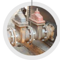
NOVÉ VENTILY DODÁVKA A MONTÁŽ
