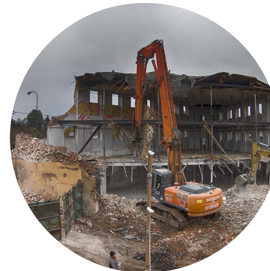
DEMOLICE OBJEKTU KASÁREN
