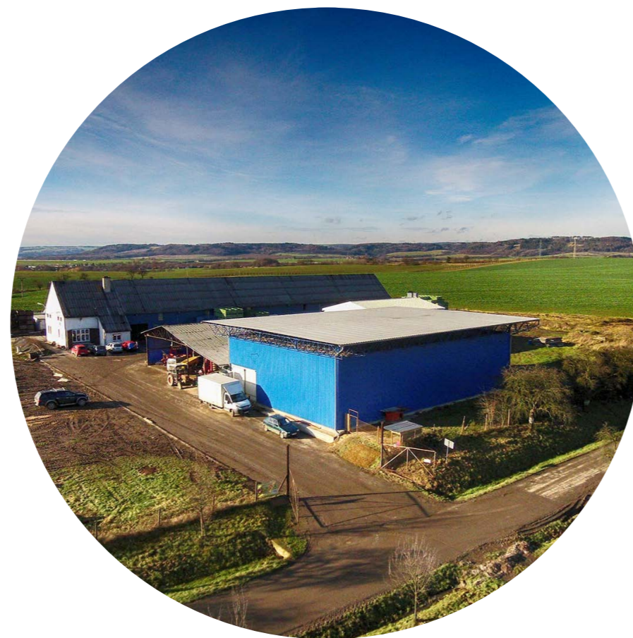
OCELOVÉ HALY A KONSTRUKCE
