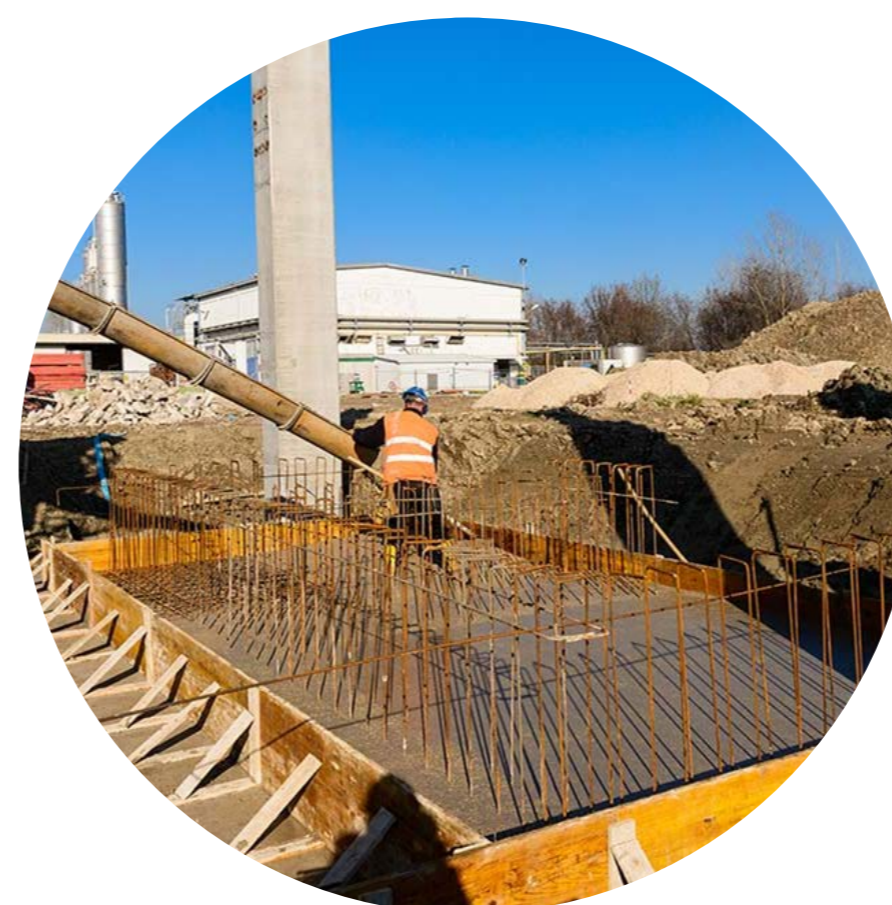
STAVEBNÍ A ZEMNÍ PRÁCE
