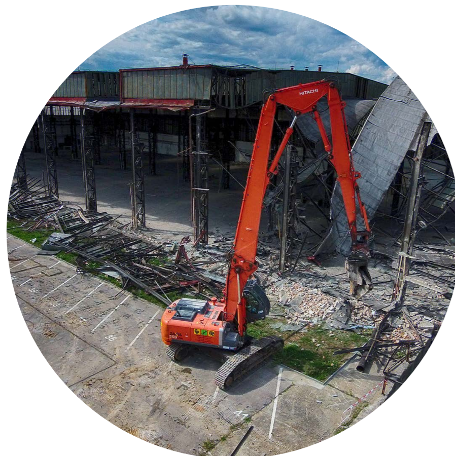
DEMOLICE VÝROBNÍ HALY
