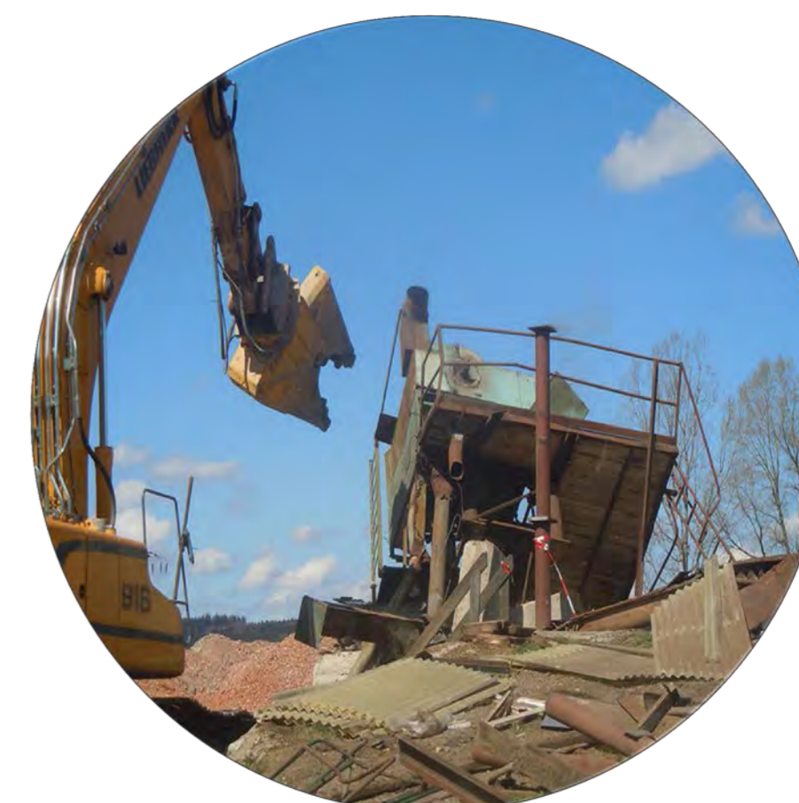
DEMOLIČNÍ S LIKVIDAČNÍ PRÁCE
